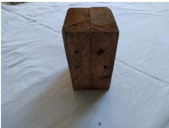
Figura 21 bloco de madeira posição 7
